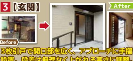
3枚引戸で開口部を広く、アプローチに手摺設置。段差は無理なく上げられる高さに調整。
